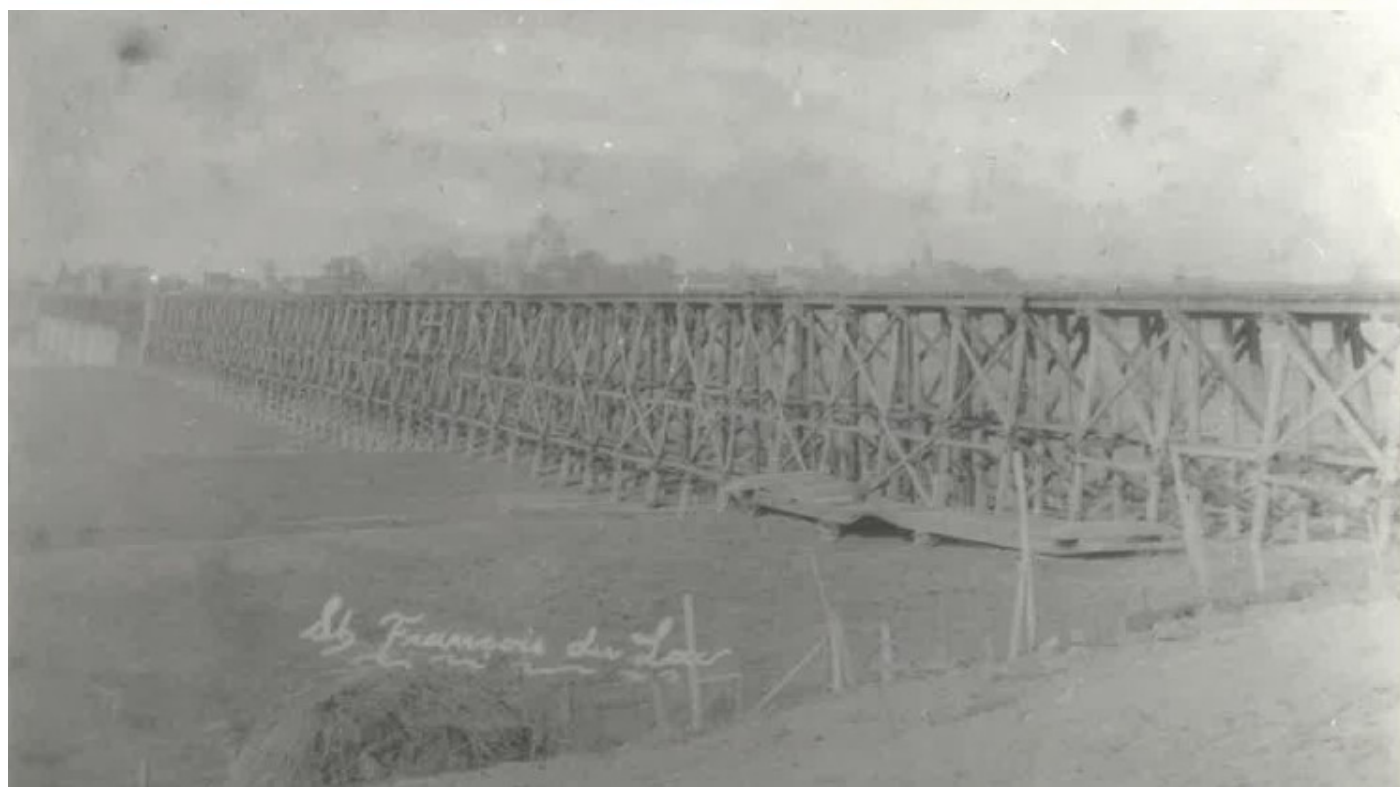
Entrée du pont à Saint-François-du-Lac au début du XXe siècle. Source : Archives du Séminaire de Nicolet, F085/P6335
